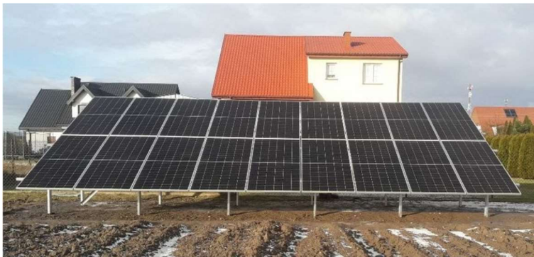
rys. 5 Środowisko instalacyjne – Konstrukcja gruntowa
